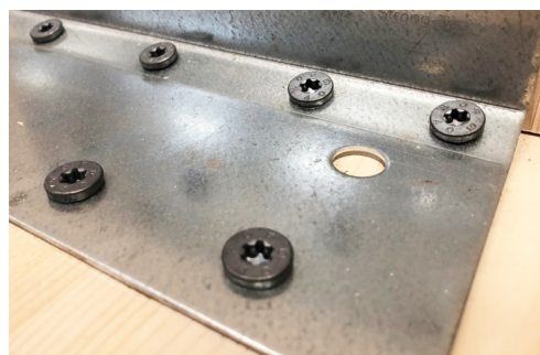
SSF-skruer til fastgørelse af AB255SSH vinkelbeslag.
