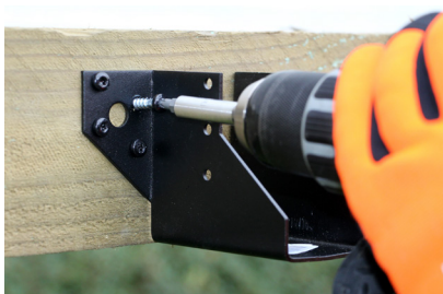
Sorlakeret SAE-PB bjælkesko fastgjort med CSA-PB beslagskruer
