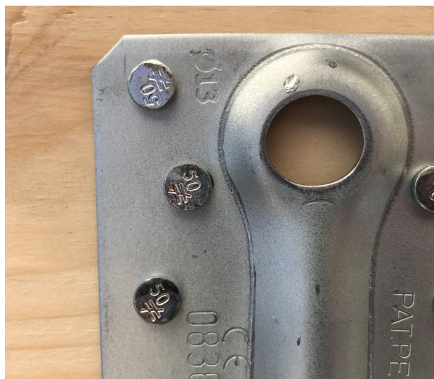
Stempler på beslagene samt længdeidentifikation på hovedet gør det let at kontrollere samlingen efter installationen.
